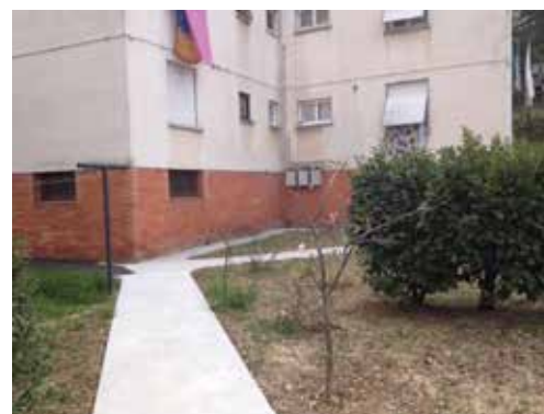
Popločene staze u sklopu zelenih površina
