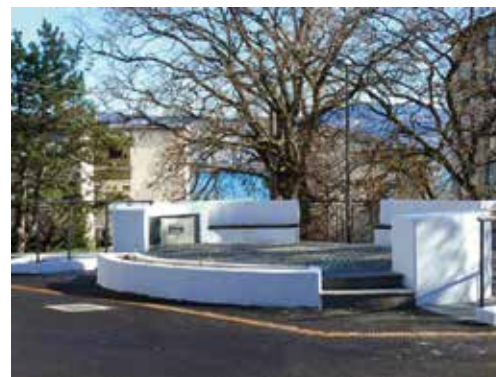
Dovršen novi trg u Borgo Zindisu
